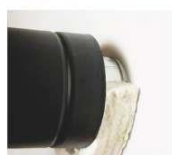
Eristä huolellisesti liitäntäkappaleen ympärillä.
