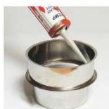
Tiivistys tiivistysmassalla liitännässä.
